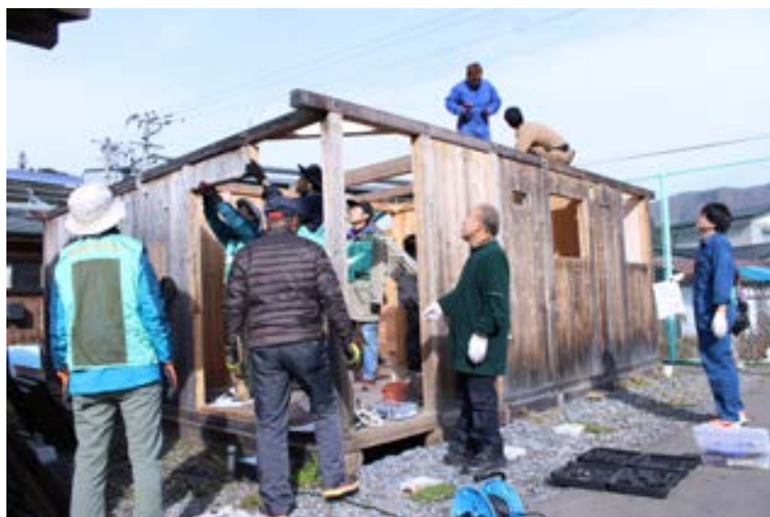
住田町仮設住宅解体の様子
