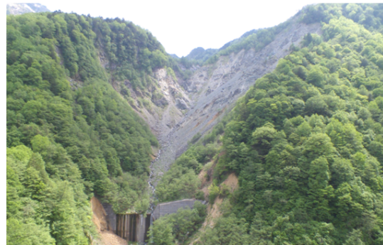
図 7 蒲田川流域の堰堤による周辺地山の変状(小飯塚, 浅井 誠二, 2014)
